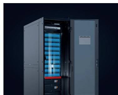
O FusionModule500 Huawei é uma solução de data center de borda de nova geração, que integra o sistema de UPS, PDU, refrigeração, monitoramento e backup de energia um único gabinete. Equipamento pré-testado, pré-instalado e pré-comissionado antes da entrega, permitindo uma rápida implantação no local. A função de monitoramento remoto baseado na Web permite O&M remoto para um único local.
